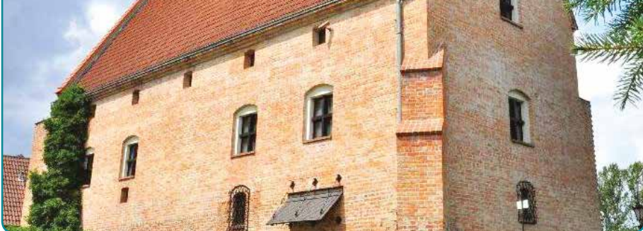
Zamek Opalińskich – odbudowane skrzydło.
